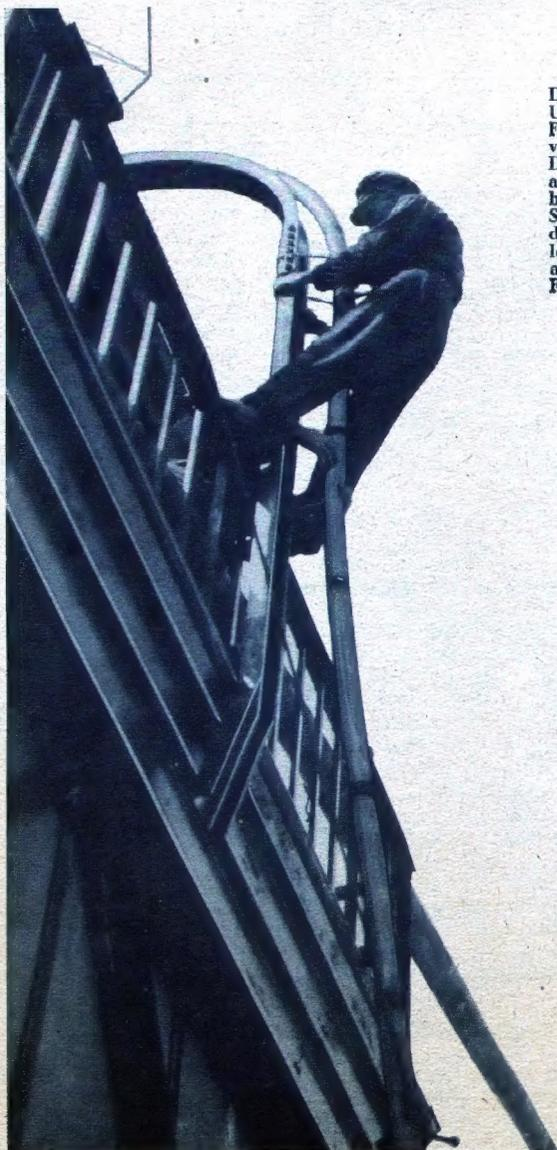
Der Weg für Ultrakurzwellen-Fernsehen wird vorbereitet. Durch das mehr als armstarke Kabel fließen die Ströme vom Sender zur ausstrahlenden Antenne auf der Spitze des Funkturms.
